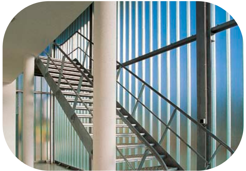
EDF sähköasema, Neuilly-sur-Marne, Ranska. Pilkington Profilit ™
